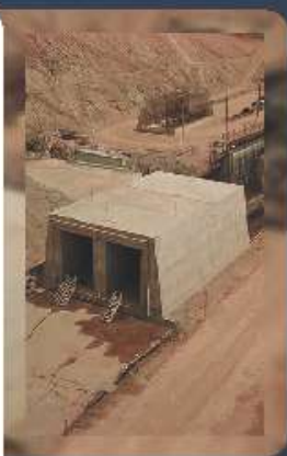
Galeria de desvio - Barragem Duas Pontes
