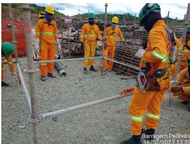
Foto 5 – Treinamentos específicos sobre Montagem de Andaimos. Data: (16/02/2023)
