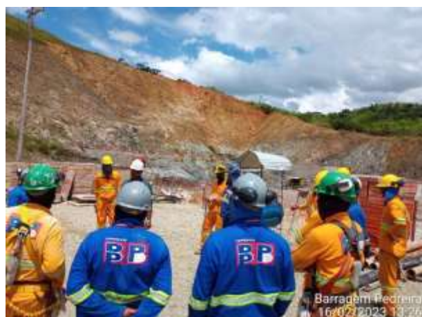
Foto 4 – Treinamento sobre Montagem de Andaime. Data: (16/02/2023).
