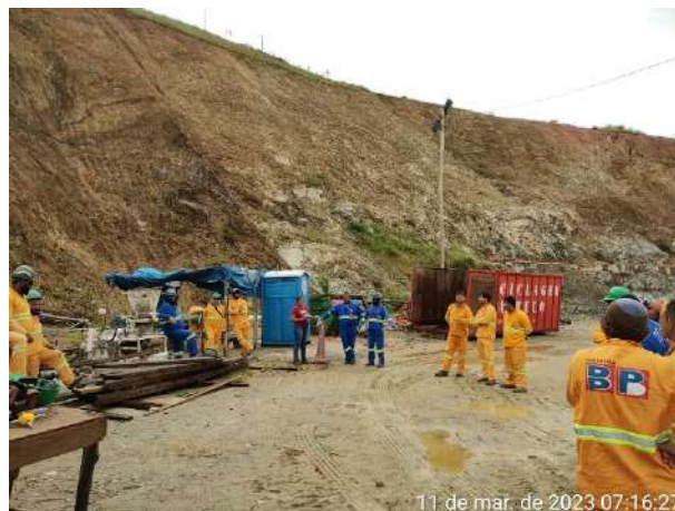
Foto 10 – DDS realizado com as equipes sobre ordem, organização e limpeza na obra – programa do 5S. Data: (11/03/2023)
